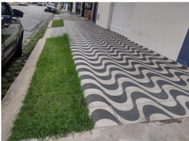
**Figura 10** - Detalhe da faixa permeável no mesmo nível da calçada com uso de gramíneas. Fonte: Autoria própria.
