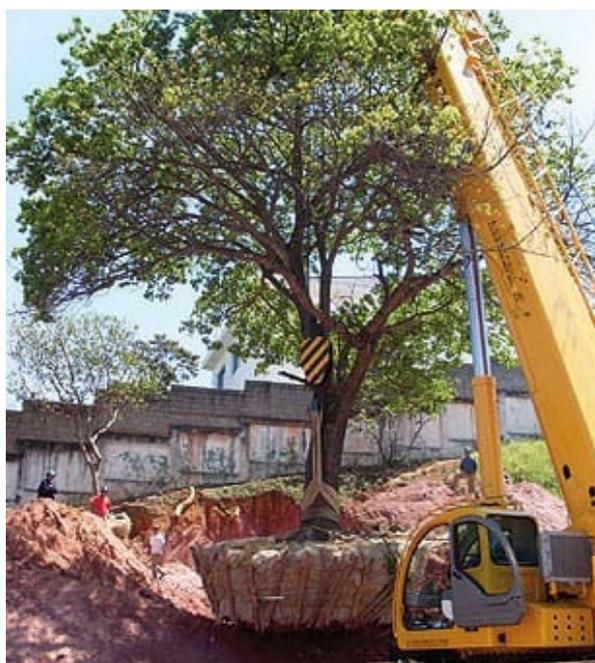
**Figura 31** - Detalhe do hasteamento da árvore por guindaste.
