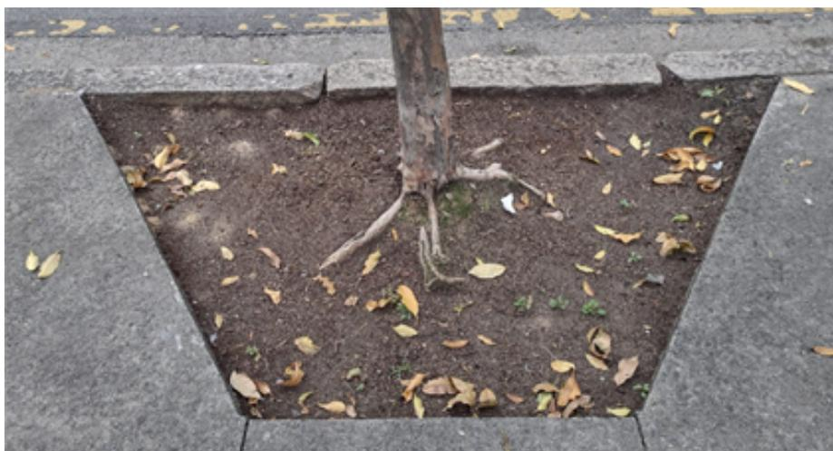
**Figura 08** - Detalhe do canteiro trapezoidal no mesmo nível da calçada. Fonte: Autoria própria.
