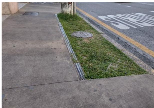
**Figuras 11 e 12** - Detalhe da rede subterrânea na faixa permeável com o uso de concregrama. Fonte: Autoria própria.
